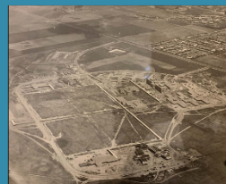
El Hospital Estatal de Fairview bajo construcción en 1958. Fuente: United Aerial Survey, fotografía N.º 1264.
